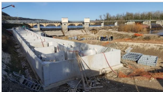
Figure 4 : Visite des travaux de la passe à poissons du barrage de Mauzac, le 16/01/2020
