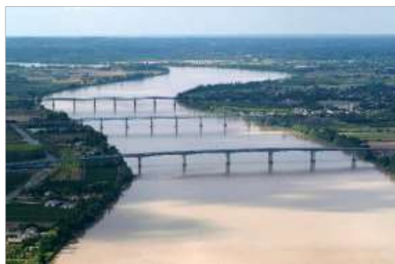
Figure 4 : Les 3 ponts de Saint-André de Cubzac (Source : EPIDOR)
