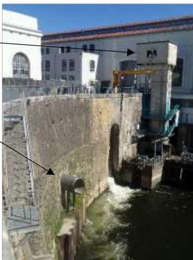
Figure 132 : Ascenseur à poissons du barrage de Tuilières (Source : EPIDOR, 2016)
