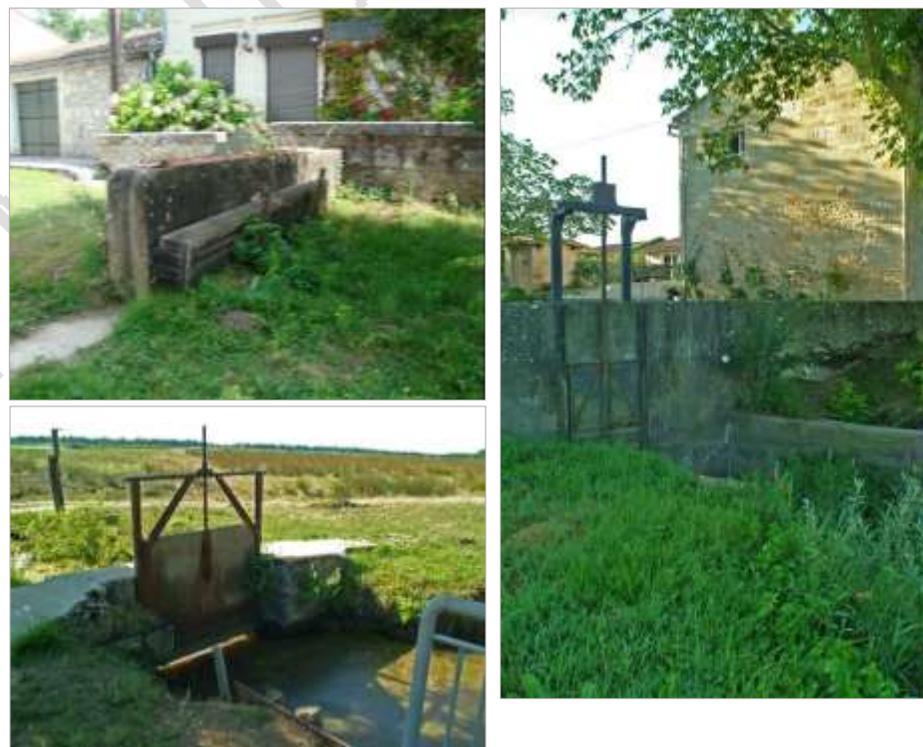
Figure 65 : Muret et dispositif de batardeau au port de Perpignan (vue de gauche) ; vanne d'ouverture-fermeture de jalle (vues de droite et du bas) (Source : EPIDOR)
