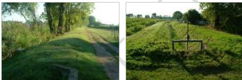
Figure 61 : Digue en bordure de Dordogne (photo de gauche) et ouvrage hydraulique de type vanne ou pelle, secteur des palus de basse Dordogne (Source : BORDES, 2006)
