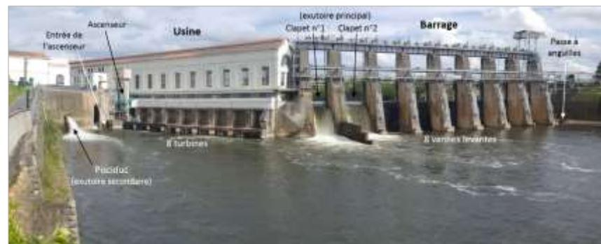
Figure 59 : Barrage hydroélectrique de Tuilières (Source : EPIDOR)
