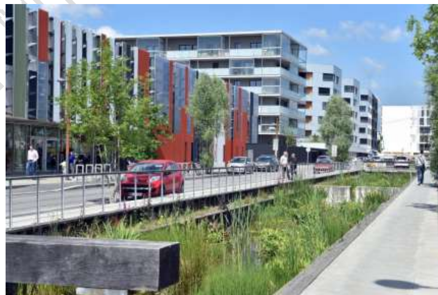
Figure 30 : Eco-quartier Mail Haroun Tazieff, exemple de mise œuvre de noues végétalisées (Source : Nantes Métropole Aménagement, 2017)
