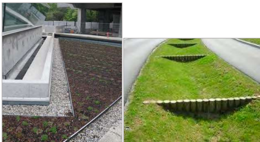
Figure 28 : Exemple de toit terrasse végétalisé (photo de gauche) et de noue compartimentée (photo de droite) (Source : CUB, 2014)
