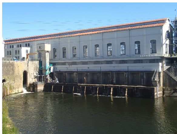
Barrage hydroélectrique de Tuilières partie aval
